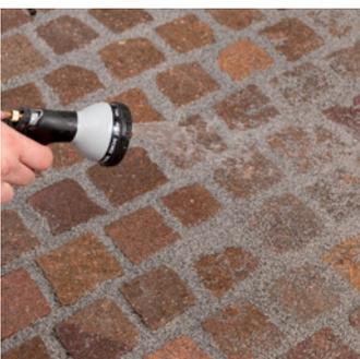
Eine leichte Beregnung führt zu einer höheren Verdichtung der Fugen. Den Wasserstrahl nicht direkt auf die Fugen richten.
