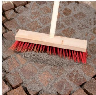
Den Mörtel mit einem Straßensbesen oder Gummischieber tief, fest und verdichtet in die Fugen einbringen.
