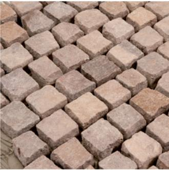
Nach einer optimalen Vorbereitung des Steingutes kann nun mit der Verfugung begonnen werden. Fuge auf mind. 30 mm Tiefe reinigen.
