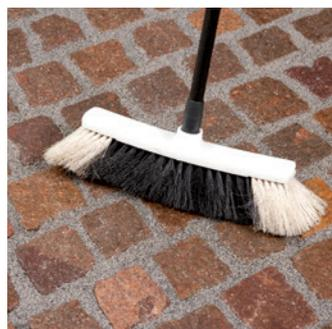
Die verbleibenden Mörtelreste mit einem Haarbesen diagonal zur Fuge vollständig einkehren.
