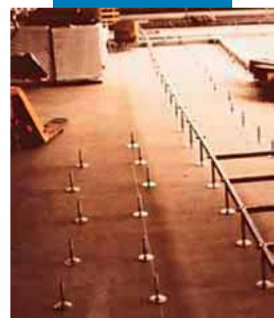
Substrat nivelat cu șapa autonivelantă Ultraplan gata pentru instalarea unei pardoseli tehnice
