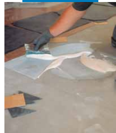
Exemplu de instalare a covorului PVC pe o suprafață nivelată cu șapa autonivelantă Ultraplan - CD2 - Milano - Italia
