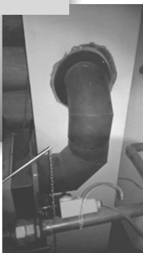
Racordare necorespunzătoare a racordului și fără dilatarea tubului de racordare
