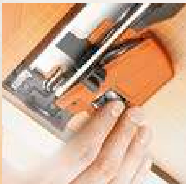
Reglarea laterală din cuplaj - dacă este necesar se poate realiza o corectare din spate, pe șina de glisare
