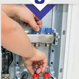
Deschideți toate ventilele și debitmetrele. Montați capacele de protecție și deschideți robinetii cu bilă.
