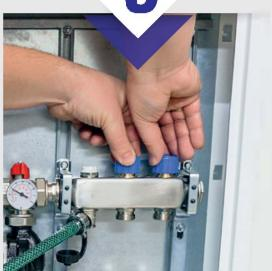
Când ati terminat închideți robinetul și simultan deschideți-l pe următorul.
