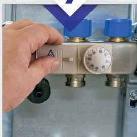
Montați STB-A pe colectorul RL și alternativ pe distribuitorul VL.
