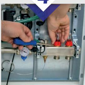
Deschideți capacele de protecție și deschideți complet debitmetrele.
