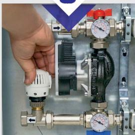
Setați capul termostatice pe temperatura dorită.(Vezi scara S.2)
