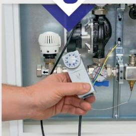
Conectați pompa cu STB-A la alimentarea cu energie electrică
