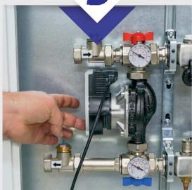
Treceți pompa de pe presiune diferențială - presiune constantă și setați înălțimea de pompare dorită.
