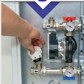
Montați capul termostatice pe robinetul de pe return.
