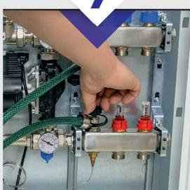
Închideți alimentarea cu apă. Închideți robinetii de umplere/golire. Deconectați furtunurile și montați capacele.
