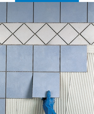
Placare pe perete din gips-carton
