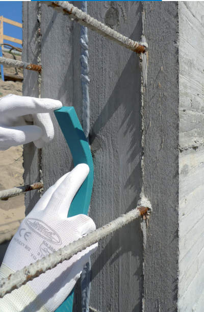
Aplicarea Idrostop Soft pe suprafețe verticale
