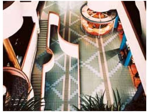
Covor ceramic din gresie porțelanată, montat cu adeziv Kerabond + Isolastic - Centrul Civic - North York Ontario (Canada)
