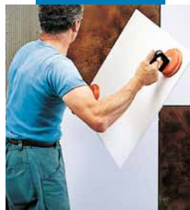
Aplicare plăci ceramice KERAION pe perete
