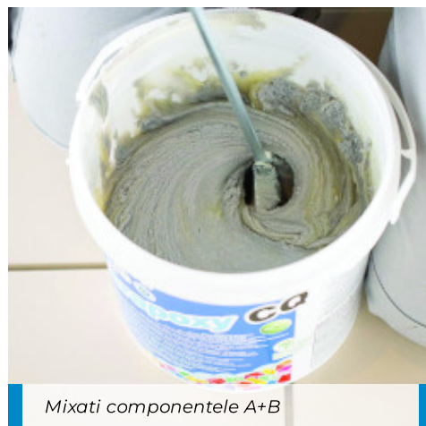
Turnati intaritorul (componenta B) in recipientul cu componenta A
