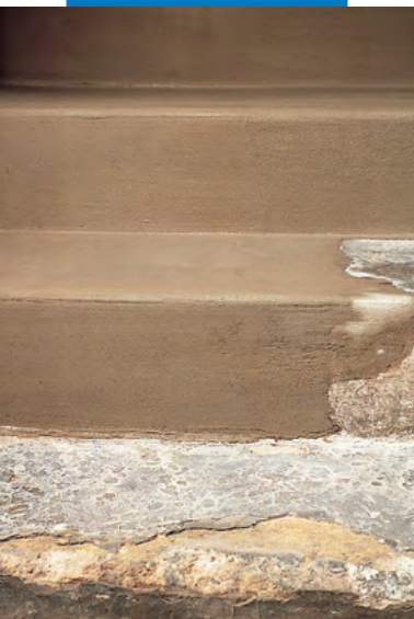
Trepte înainte și după tratamentul cu Nivorapid
