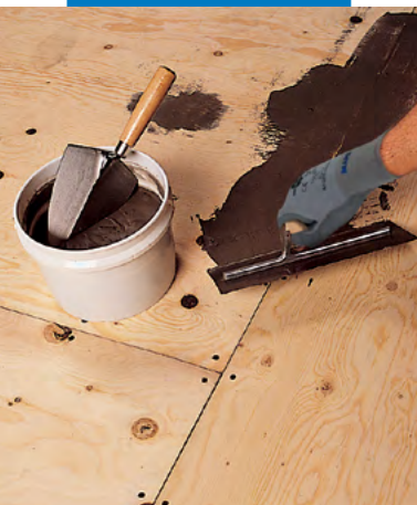
Chituirea unui suport din placaj cu Nivorapid + Latex Plus
