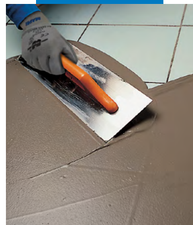
Nivelarea unei pardoseli existente cu Nivorapid
