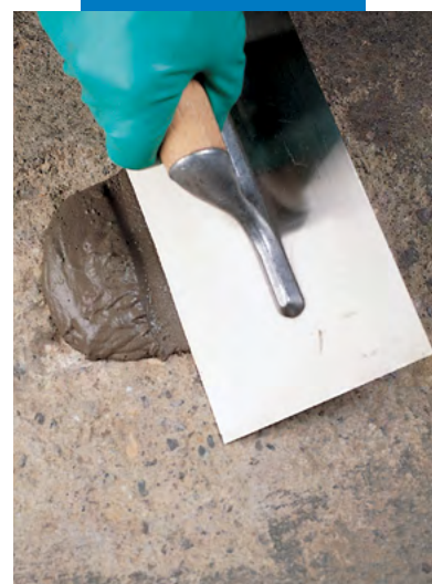
Repararea marginilor orizontale cu Nivorapid
