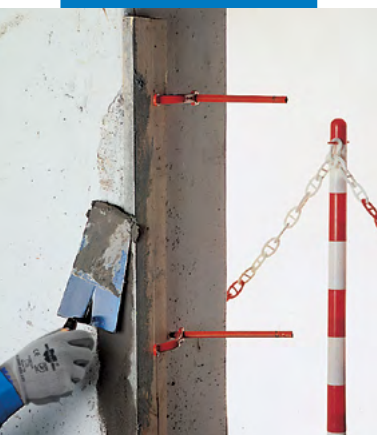
Repararea unei margini verticale cu Nivorapid
